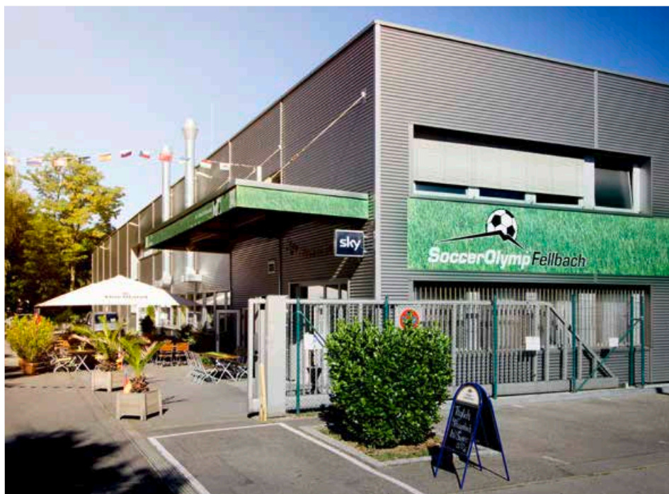
In dem ehemaligen Lagergebäude dreht sich nur beinahe alles um den Fußball. In den zwei Mehrzwecksporthallen wird auch mit anderen Sportgeräten trainiert.
